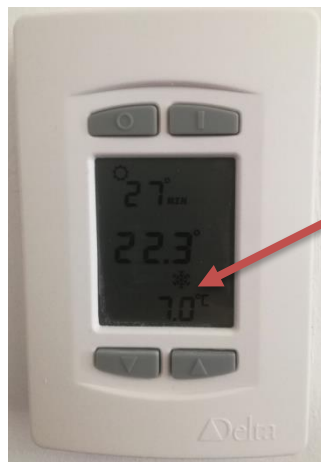
Obr. 2 - Vizualizace stavu otevření okna (7.0°C)
