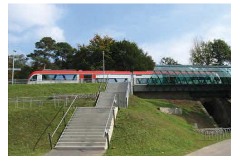
04.031 ▲ Zastřešení vnějšího nástupiště méně frekventované zastávky [zast. Darmstadt - TU Lichtwiese, Německo]. #esko #nastupiste #zastreseninastupiste #pristupnanastupiste #nemecko #darmstadt
