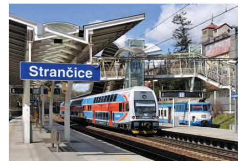
04.007 ▲ Ostrovní nástupiště ve stanici linek „S“ s mimoúrovňovým přístupem nadchodem [žst. Strančice]. #esko #cityelefant #nadchod #strančice
