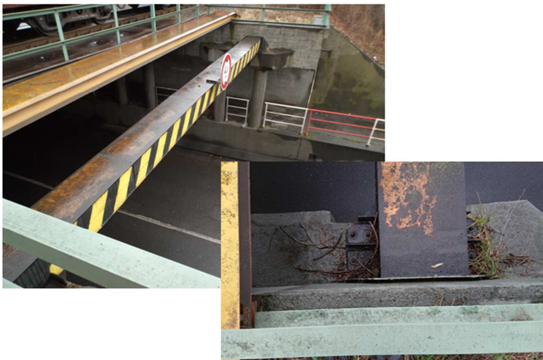
Stavba: „Oprava mostu v km 264,883, zast. Ostrava-Mariánské Hory – protinárázová zábrana“ – pohled shora, uložení, stávající stav
