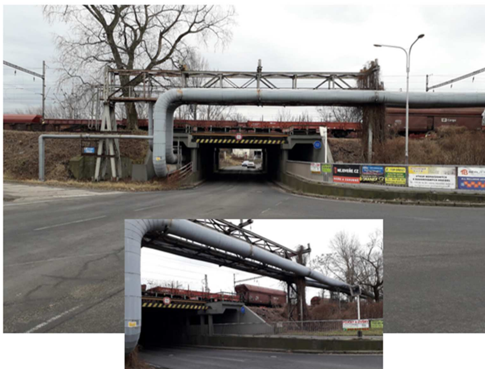
Stavba: „Oprava mostu v km 264,883, zast. Ostrava-Mariánské Hory – protinárazová zábrana“ – pohled čelní, širší souvislosti, stávající stav
