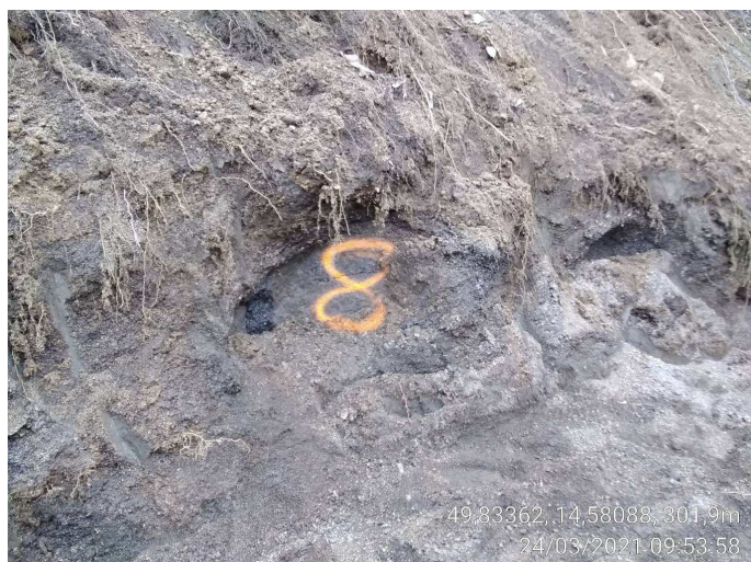
Obr.13 – balvan v km cca 0,424
