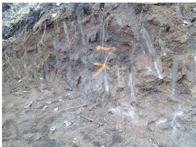
Obr. 12 – balvan v km cca 0,412
