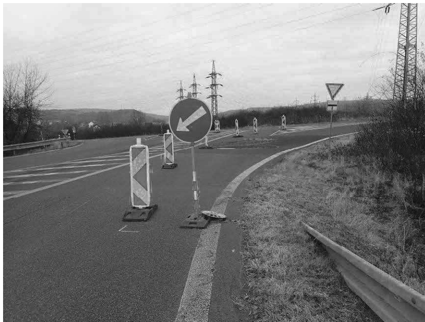
Pohled od S na provizorní zabezpečení propadu
