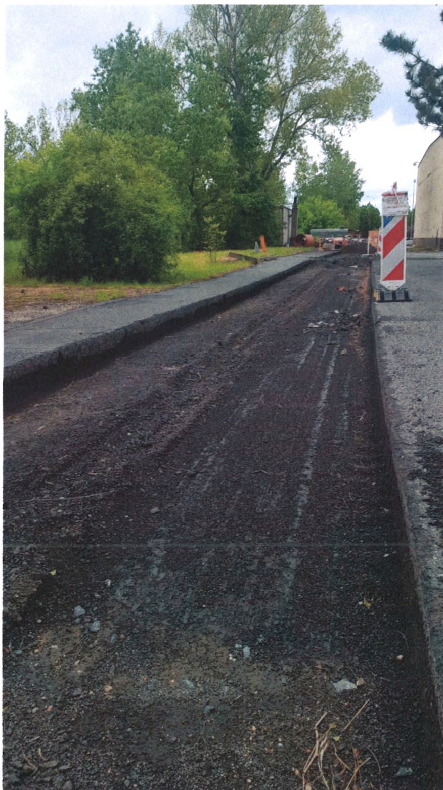
Dílčí změna 5: Změna tloušťky odstraněných zpevněných povrchů
