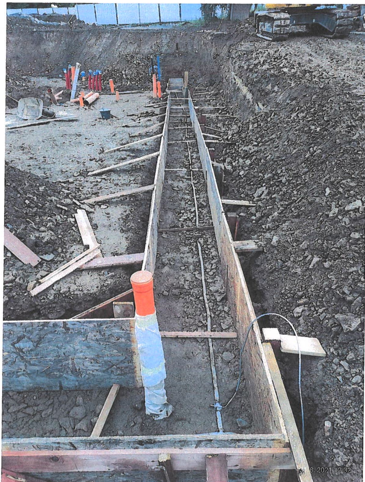
OBR 2 - SO 03 - rýha vč. bednění po základový pas
