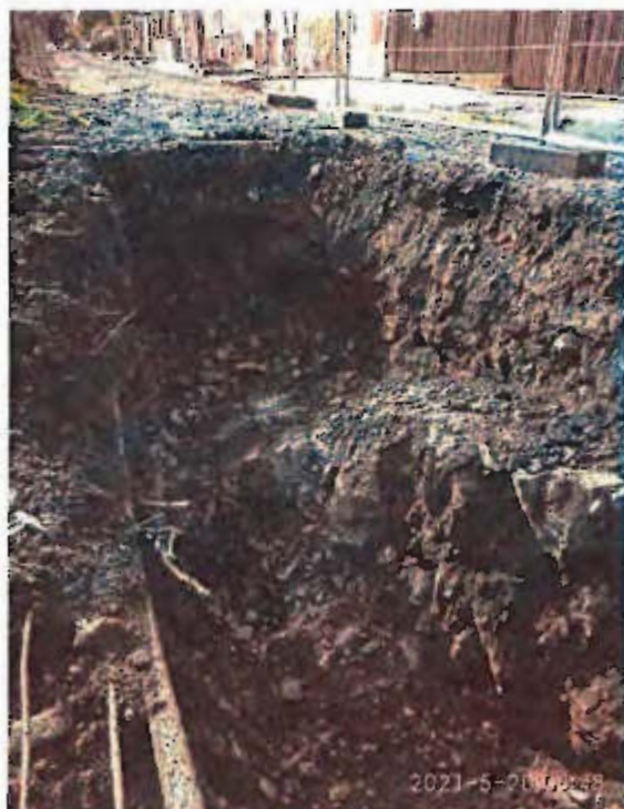
Obr. 4 – konstrukce vozovky a jílovitý štěrk
