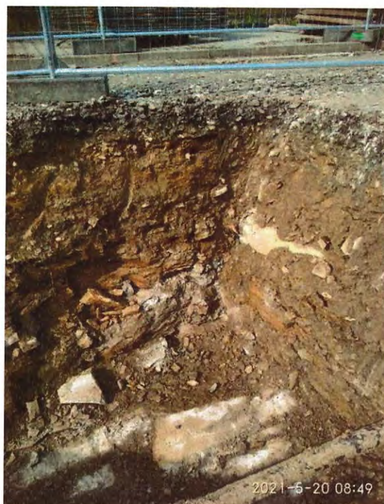
Obr. 3 – celkový pohled na výkop
