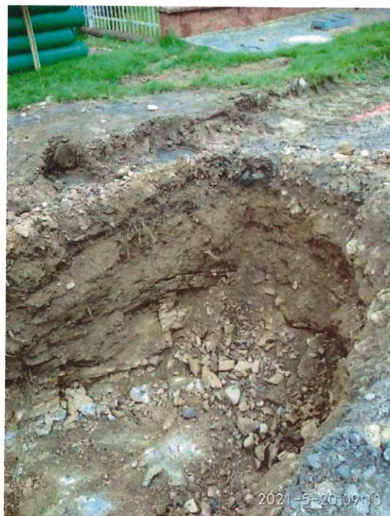
Obr. 9 – dno výkopu – zdravá pararula
