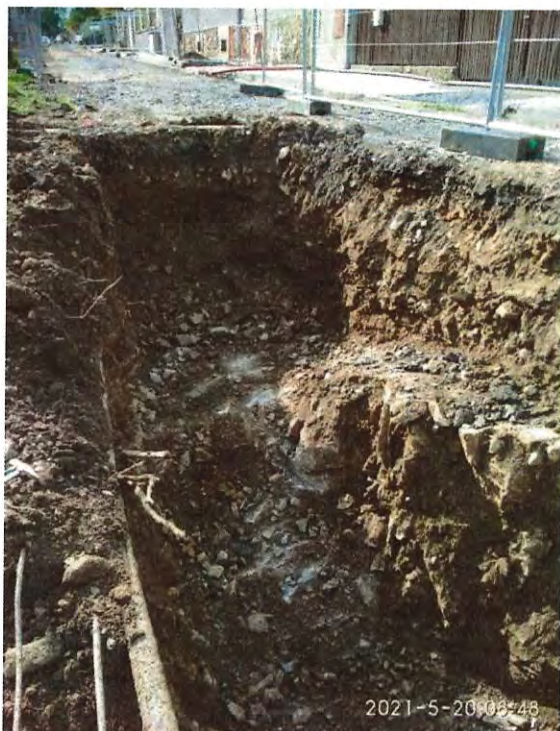
Obr. 4 – konstrukce vozovky a jílovitý štěrk
