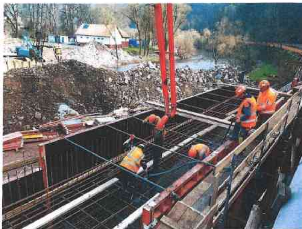
Obrázek 1 - SO 201/OP 4 – betonáž základu dířku opěry
