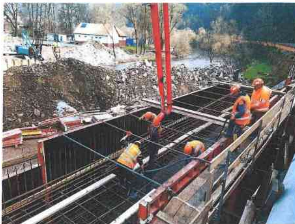
Obrázek 1 - SO 201/OP 4 – betonáž základu dílku opěry
