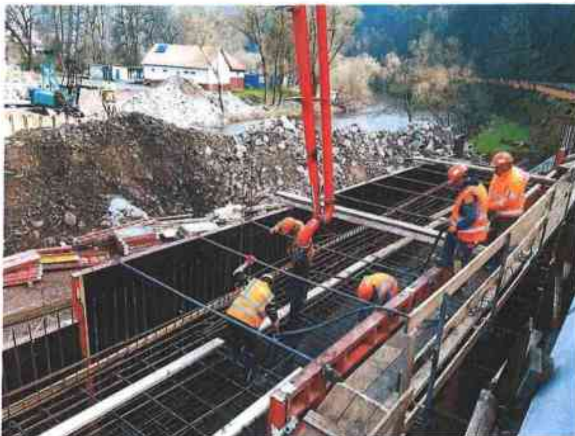
Obrázek 1 - SO 201/OP 4 – betonáž základu díku opěry
