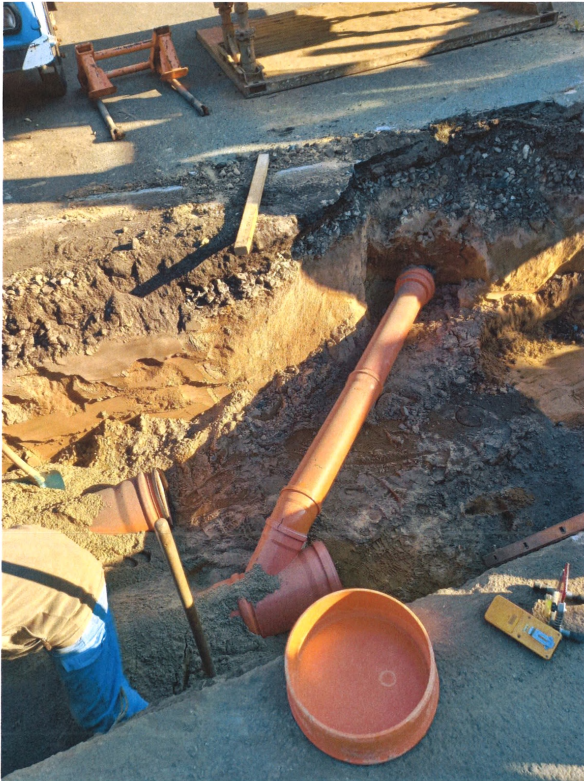
Dílčí změna 2: Přepojení stávajících svodů na nově budovanou kanalizaci
