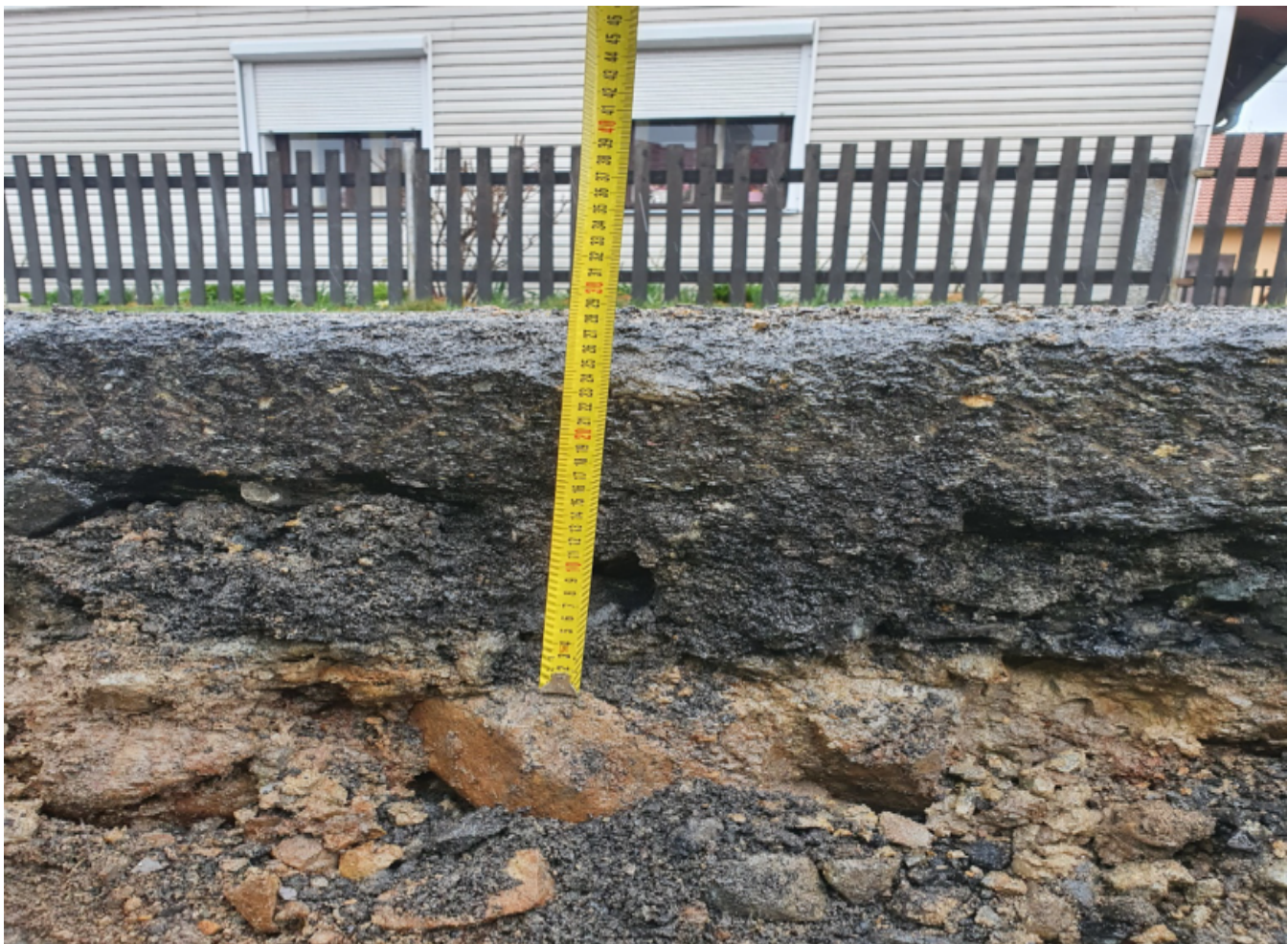
pohled na zastižený kamenný štět v podloží vozovky
