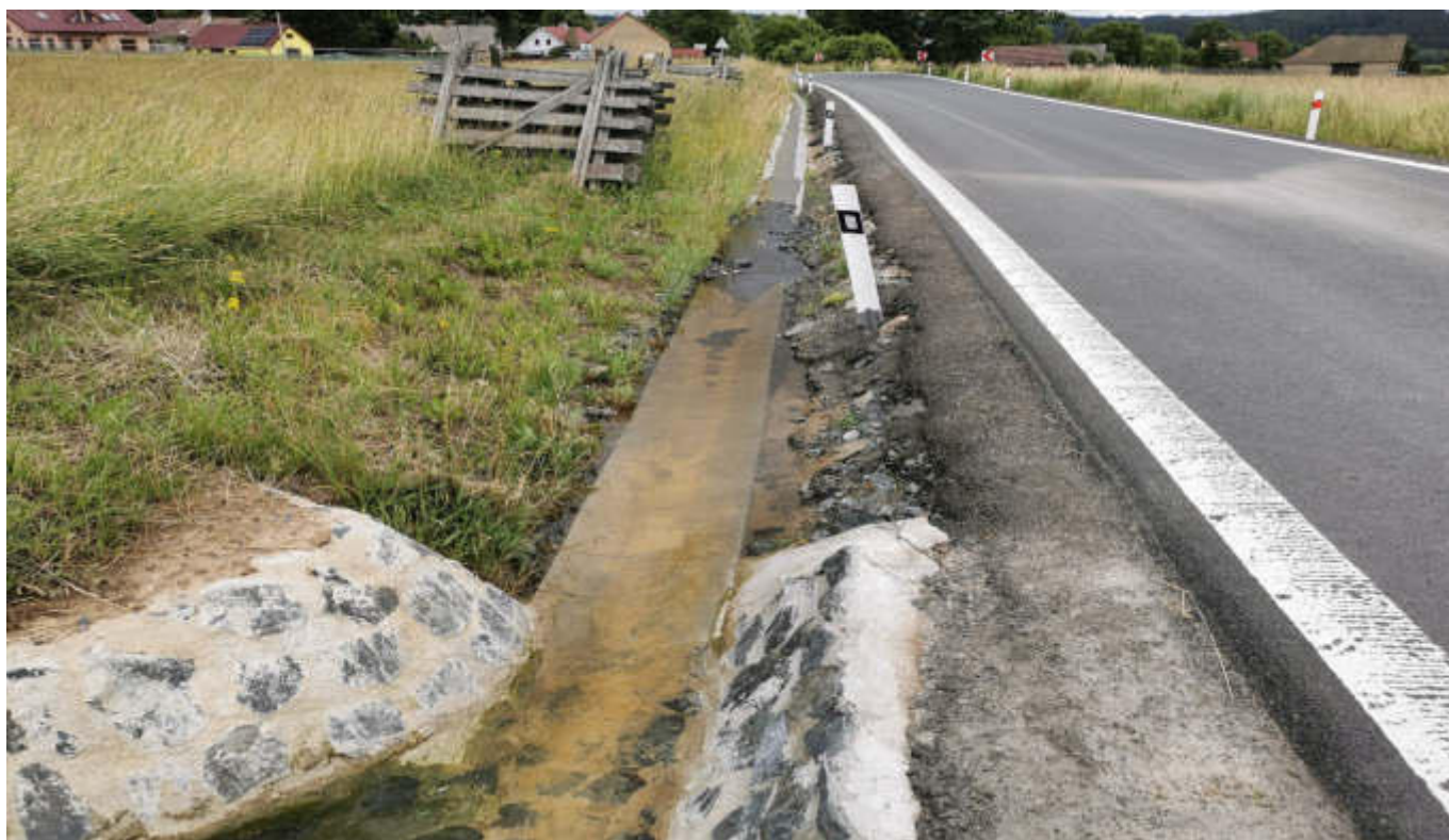
pohled na pravostř. příkop (směr Mýta)
