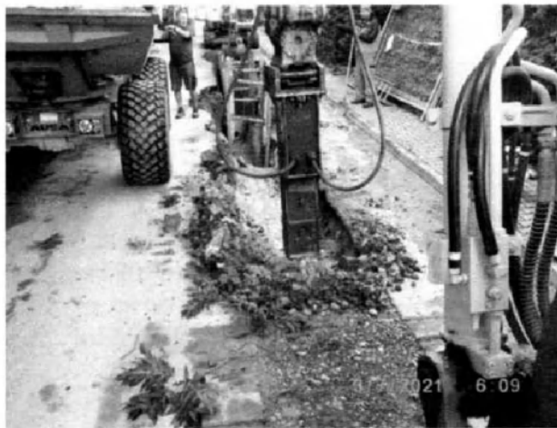
Obr.2 – rozrušování horniny ve výkopu
