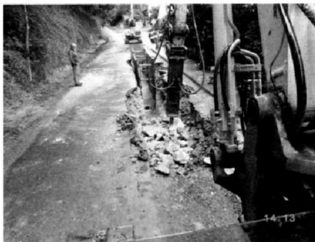
Obr. 4 – rozrušování horniny ve výkopu
