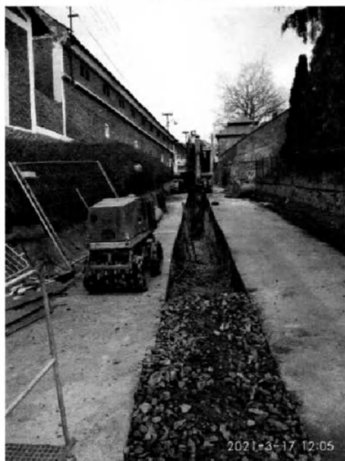
Obr. 3 – celkový pohled na výkop
