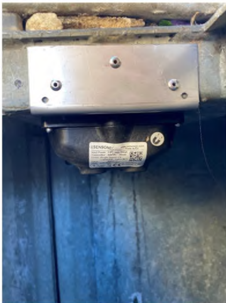
Obrázek 1: Správná instalace senzoru
