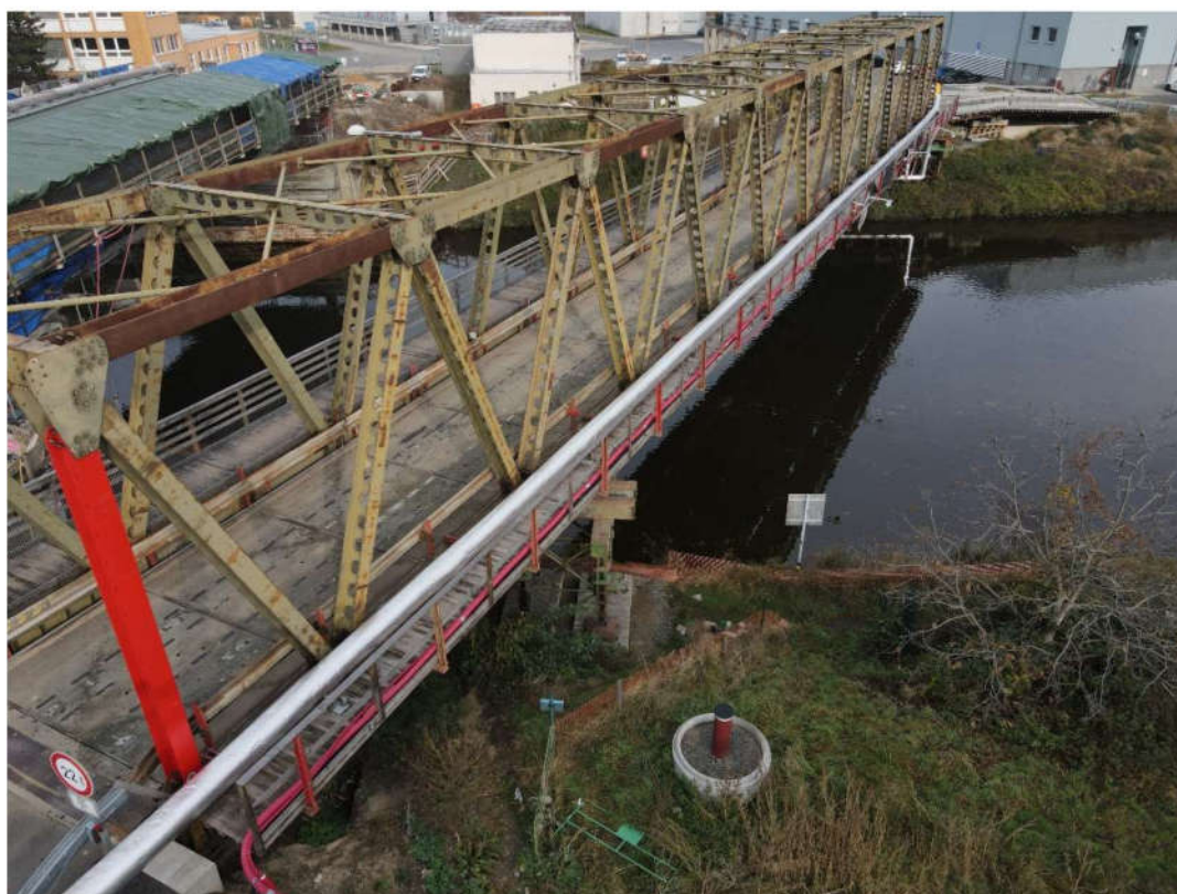
Vodovod – izolovaný na mostě
