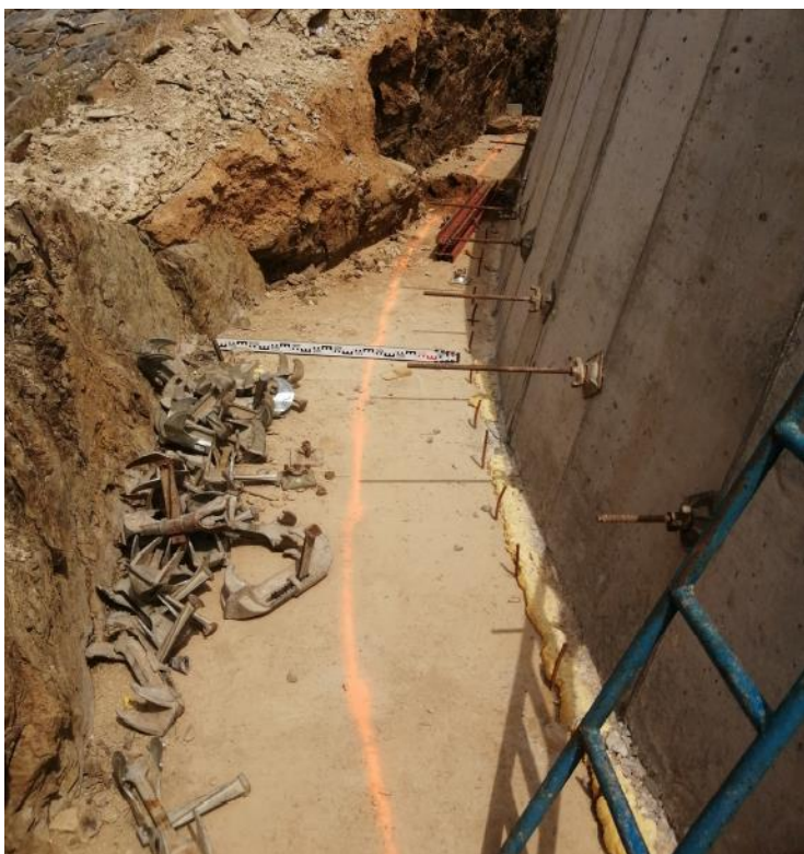
Obr. č.4 – nadvým v úrovni podkladního betonu monolitické konstrukce přelivné zdi
