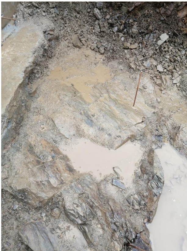
Obr. č.7 – základová spára pod blokem č.1
