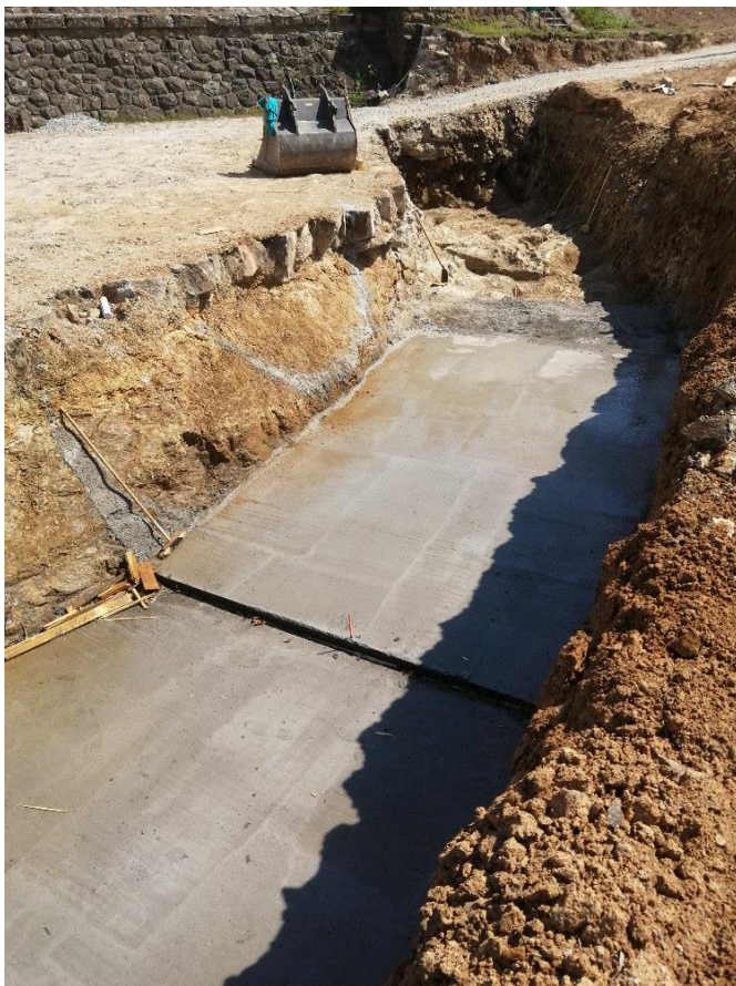
Obr. č.3 - podkladní beton po prohloubení základové spáry
