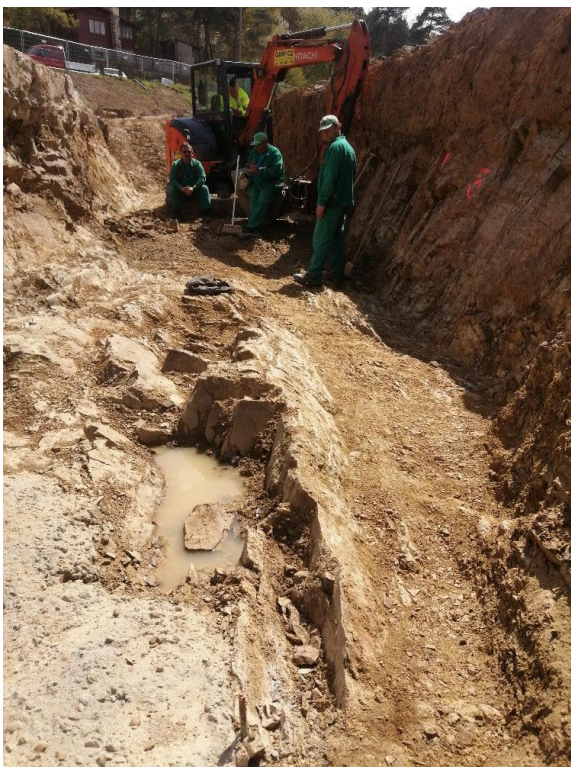
Obr. č.1 – základová spára na nezvětralém skalním podloží
