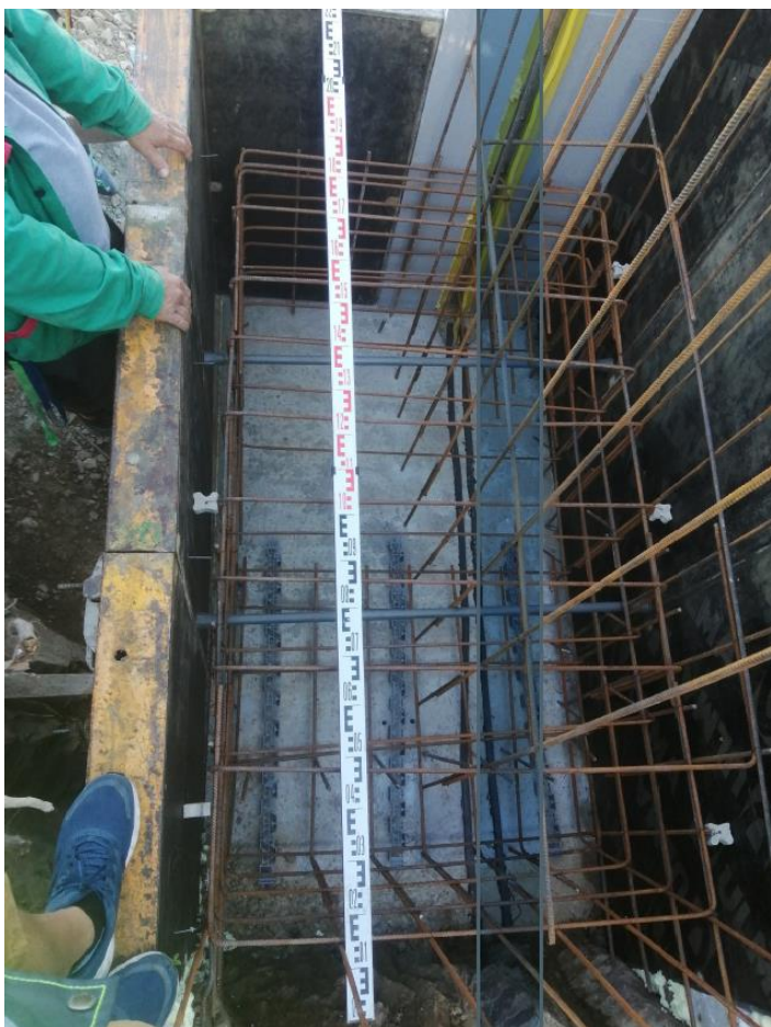
Obr. č.5 – prodloužení zavazovacího bloku č. 0-B do skalního podloží v úrovni 275,50 m.n.m.
