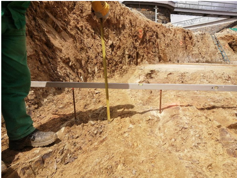
Obr. č.2. – Prohloubená základová spára
