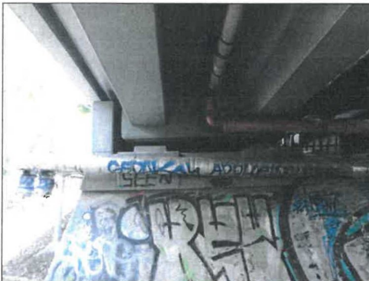
Pohled na opěru O11.
