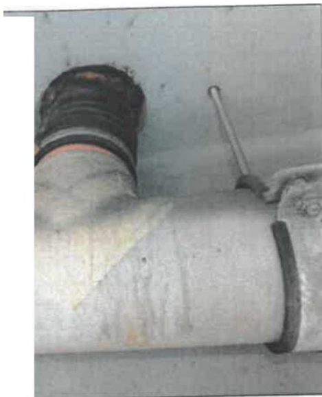
Koroze svislých svodů z odvodňovačů do podélných liniových.
