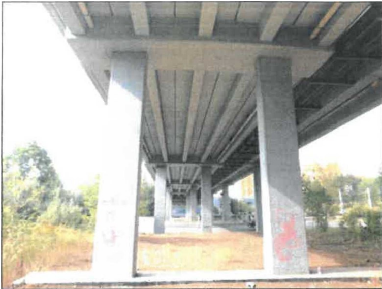
Pohled z pole 5 proti směru staničení.
