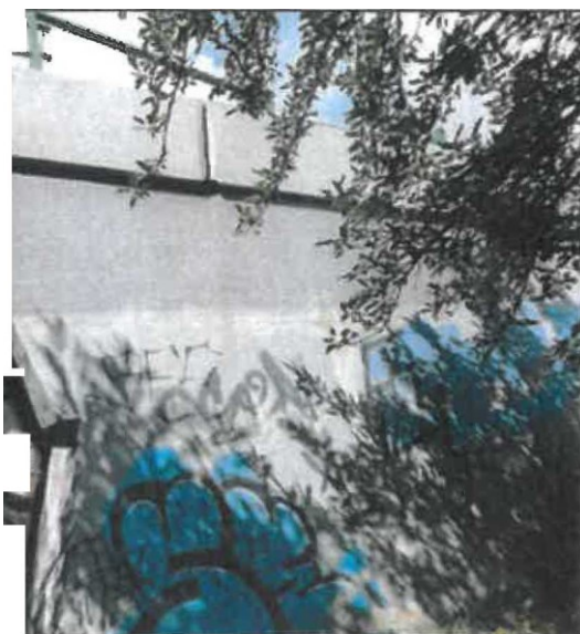
Na pravém boku opěry O11, patrně v pracovní spáře úložný práh/dřek a úložný práh/plentovací stěna jsou v nátěru trhliny patrně se slabými výluhy.
