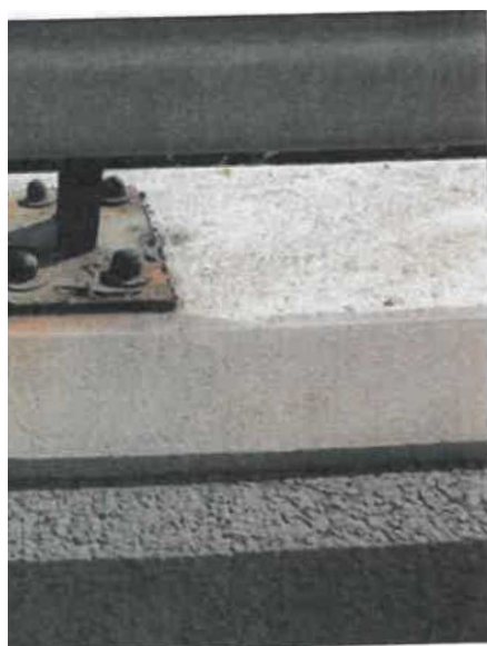
Degradace protikorozní ochrany zádržného systému, nejhorší stav je na předmostí opěry OH vpravo - již nefunkční protikorozní ochrana, silná koroze.
