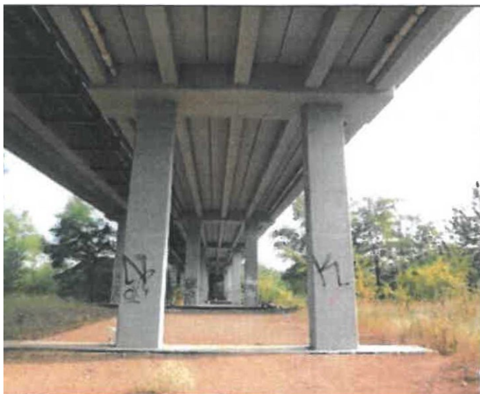
Pohled z pole 4 ve směru staničení.
