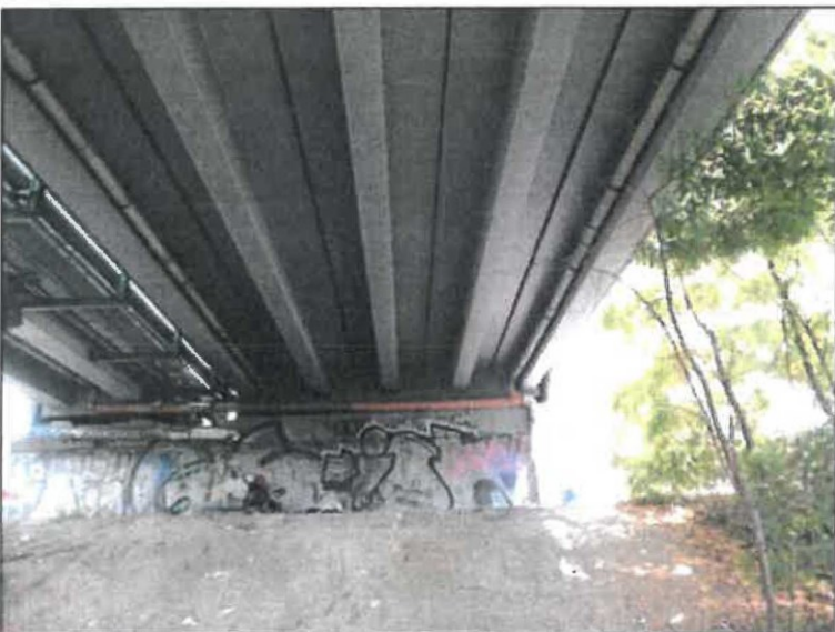
Pohled na opěru O11.
