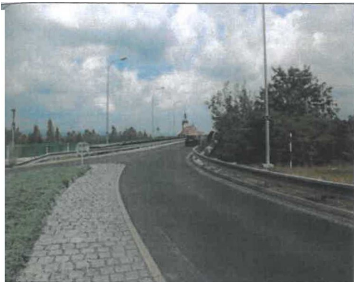
Pohled ve směru staničení - nájezd na most.
