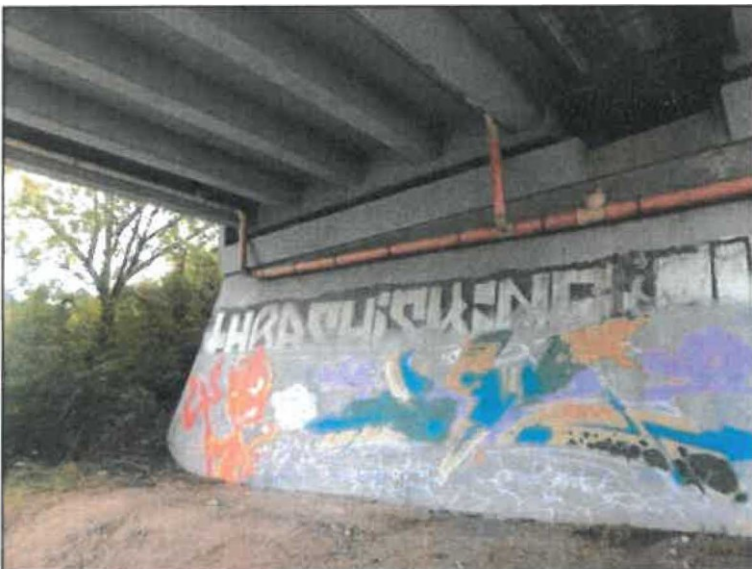
Pohled na opěru O1.
