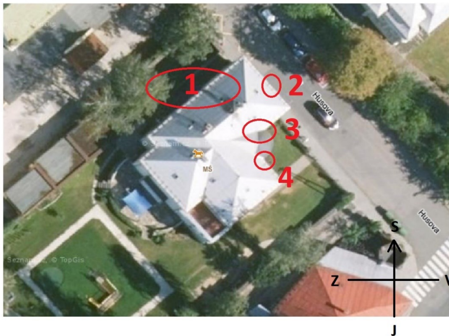
Kritická místa budovy
