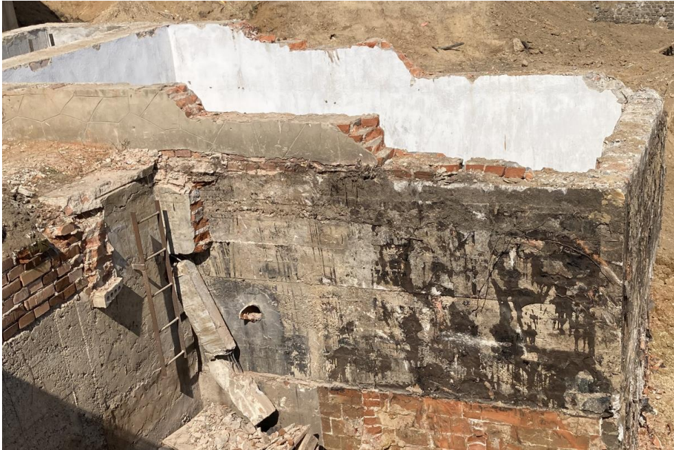
Obr. 1 – zděné stěny MK
