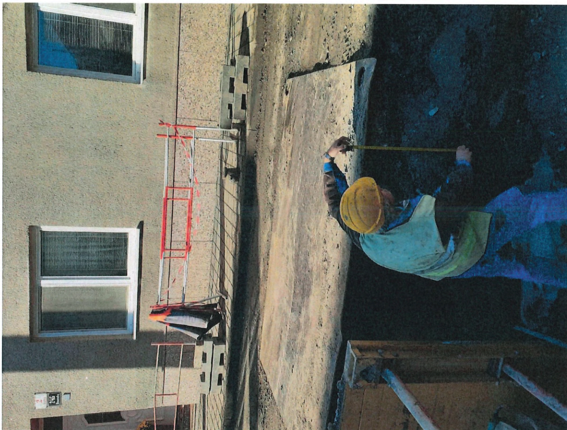
Foto č. 2 - měření tloušťky vrstvy živice - Vratná 7
