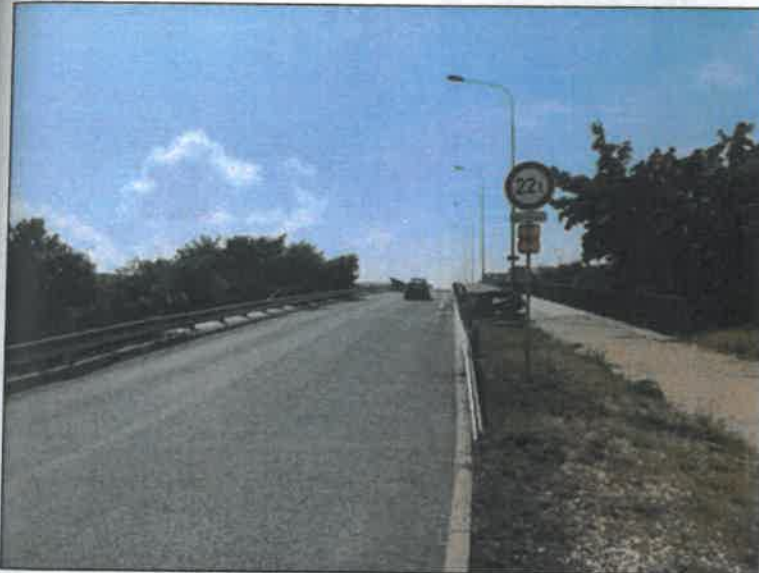
Pohled proti směru staničení.
