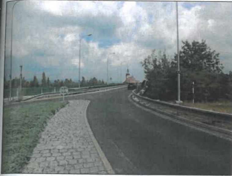
Pohled ve směru staničení - nájezd na most.
