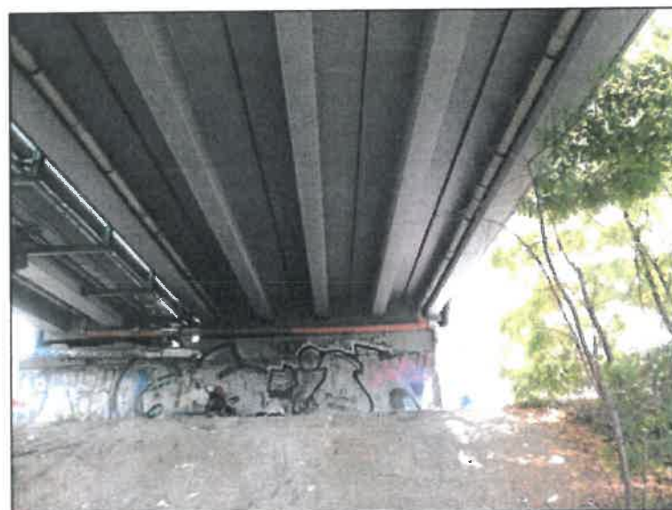
Pohled na opěru O11.
