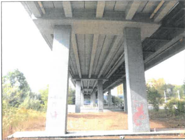
Pohled z pole 5 proti směru staničení.
