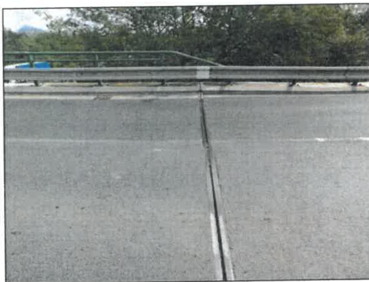
MZ nad O1 částečně zanesený.
