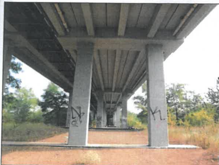
Pohled z pole 4 ve směru staničení.
