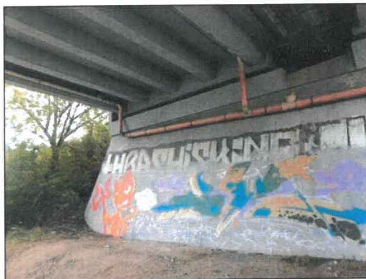
Pohled na opěru O1.
