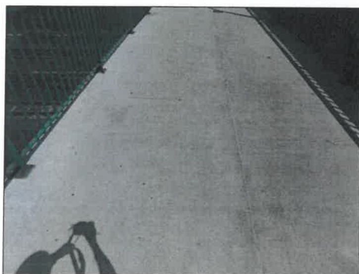
Viz předchozí, dále prokreslené korodující obrysy poklopů svrasky revizní šachty skrze pochozí vrstvu.
