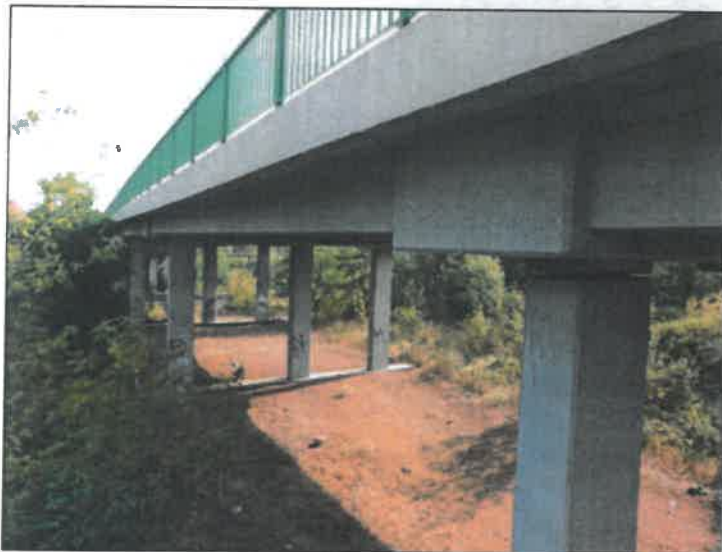
Pohled ve směru staničení zleva od poiliře P4, ve směru staničení.
