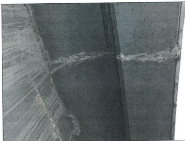
Na boku převisu působí trhlina jako sanovaná, opakovaně prokreslená šířky do 0,1 mm.
