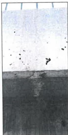
Na boku převisu působí trhlina jako sanovaná, opakovaně prokreslená šířky do 0,1 mm.
