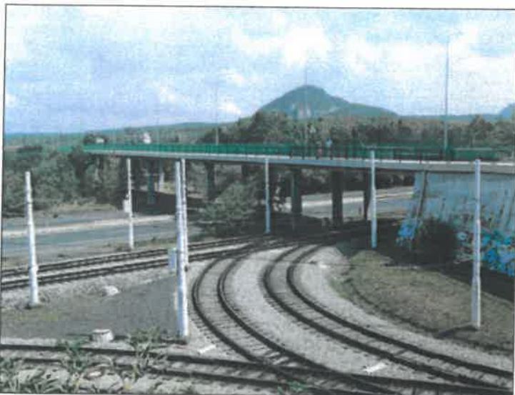
Pohled na konstrukci zleva od centra.
