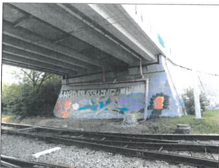
Pohled na opěru O1 a navazující opěrnou stěnu.
