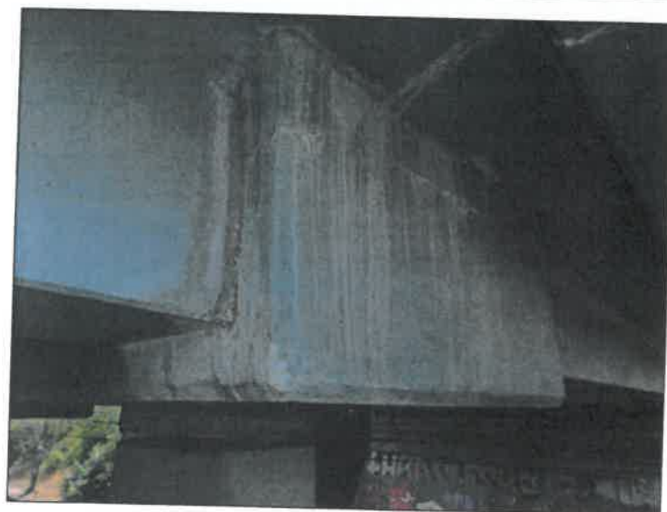
Stopy po zatékání na pilíř P2.
