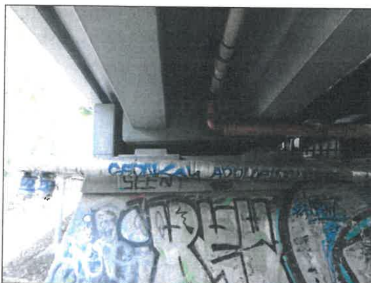
Pohled na opěru O11.
