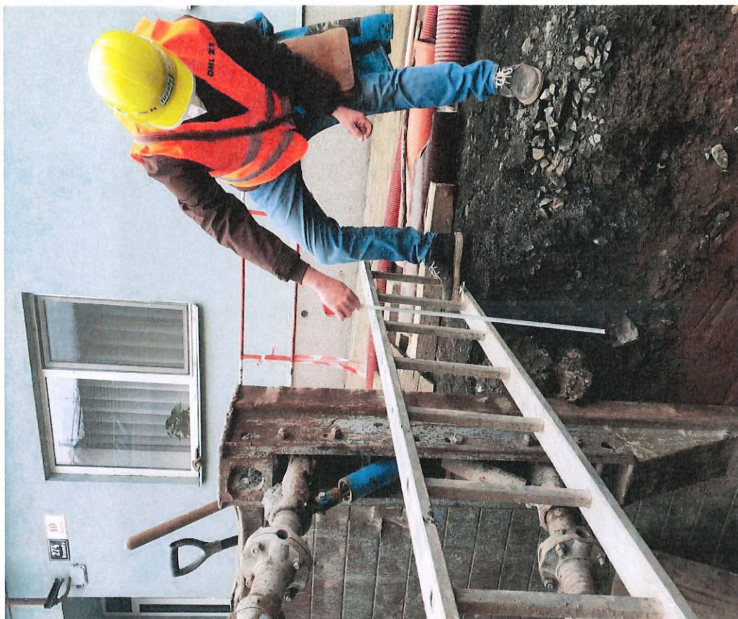
Foto č. 3 - měření tloušťky vrstvy živice - Vratná 10
