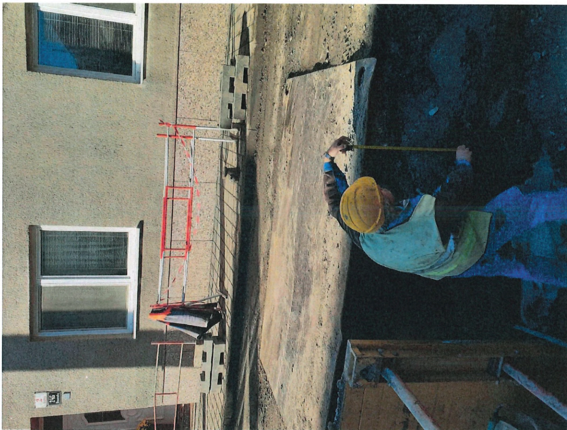
Foto č. 2 - měření tloušťky vrstvy živice - Vratná 7
