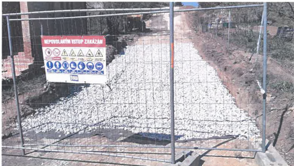
Výměna podloží při výjezdu z ul. Hradiska
