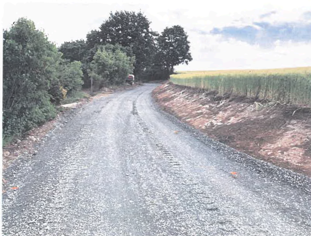
Podkladní vrstvy v místě změněné trasy
