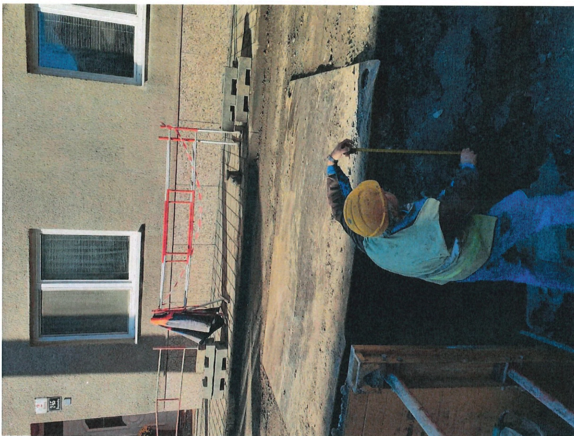
Foto č. 2 - měření tloušťky vrstvy živice - Vratná 7
