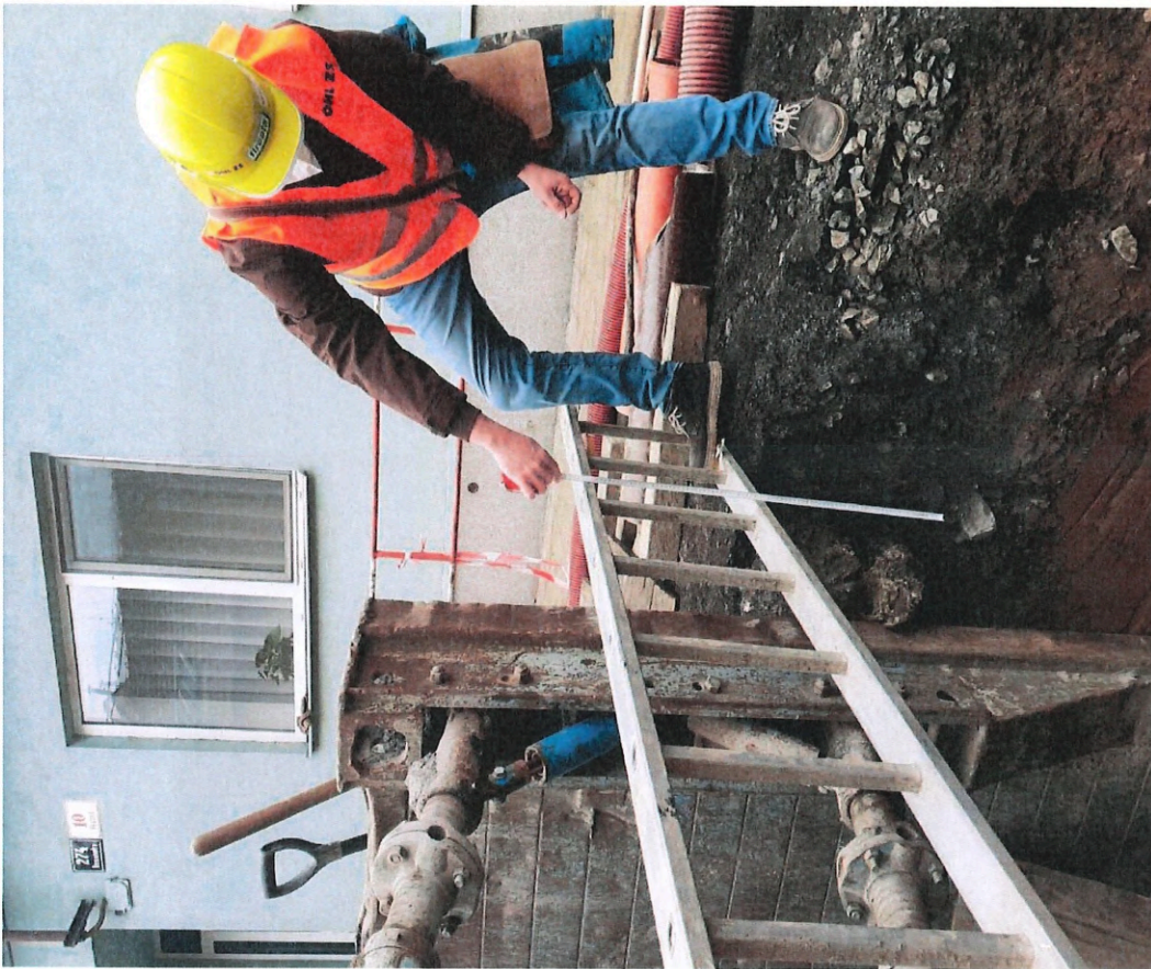
Foto č. 3 - měření tloušťky vrstvy živice - Vratná 10
