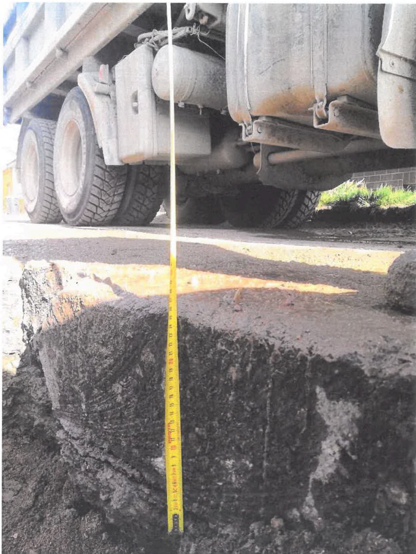
Foto č.1 – před objektem Hoštická, č.p. 31, bod 1 dle situace zaměření
