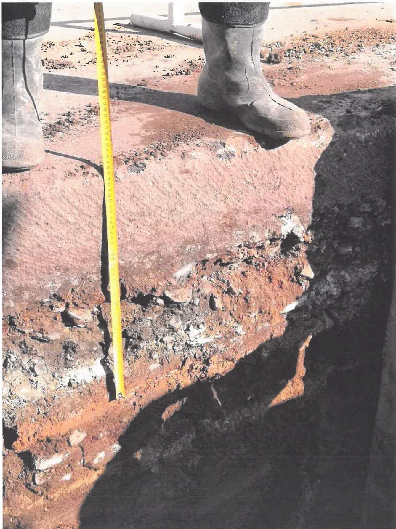
Foto č.4 – před objektem Hoštická, č.p. 40, bod 4 dle situace zaměření
