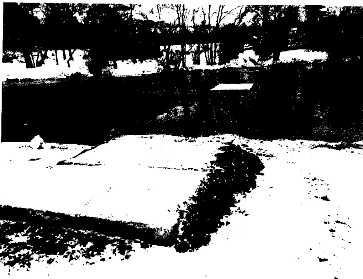
Obrázek 3 SO 901 – příprava pro věže na provizorní lávku
