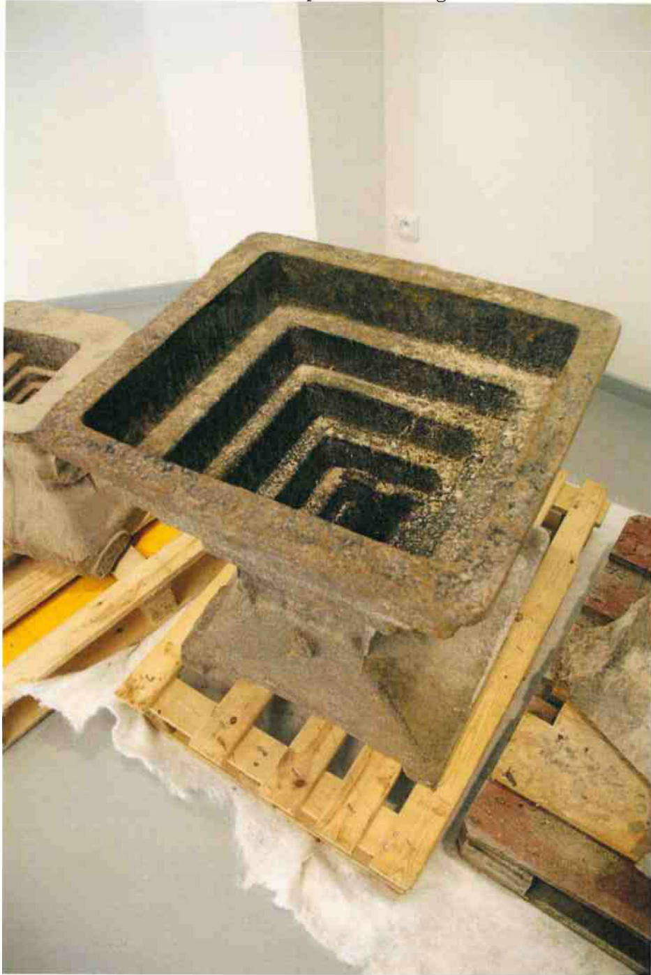
Hlavní střílna lehkého objektu Rozměry přibližně 65 x 65 x 60 cm Hmotnost přibližně 350 kg
