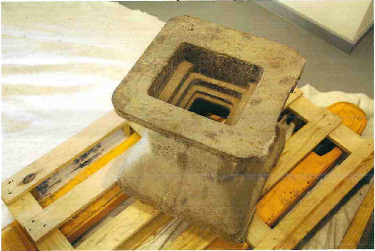
Střílna těžkého objektu Rozměry přibližně 45 x 45 x 45 cm Hmotnost přibližně 200 kg
