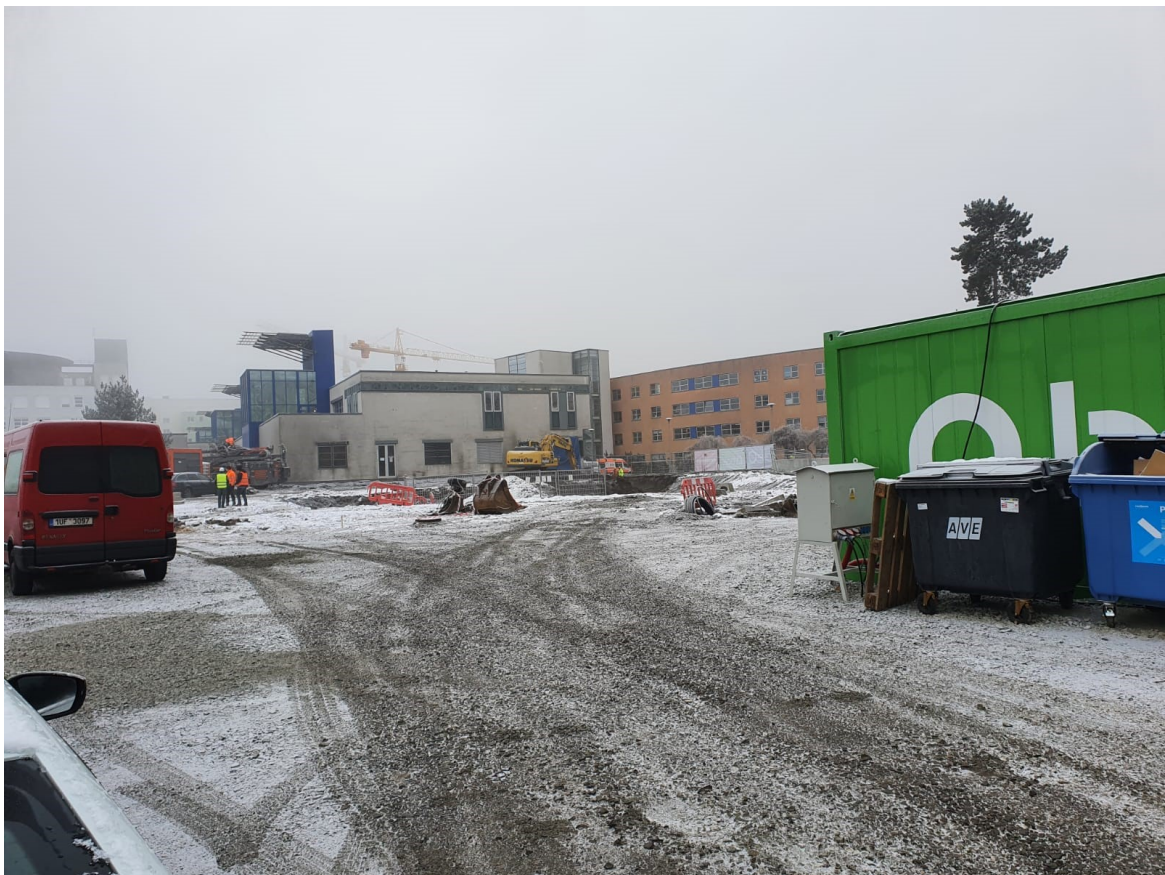
Fotografie z probíhající výstavby:
