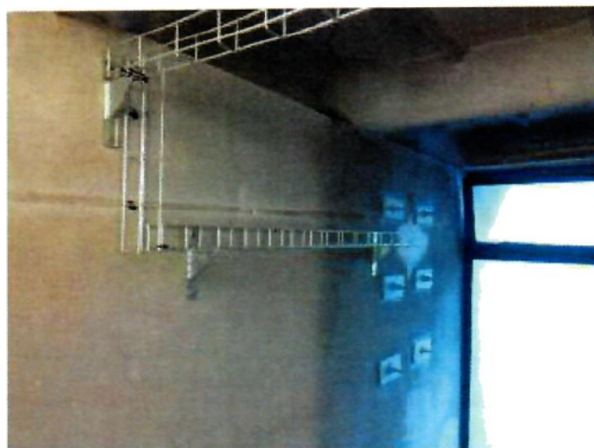
Obr.2 – kotvení stožáru a kabelová trasa
