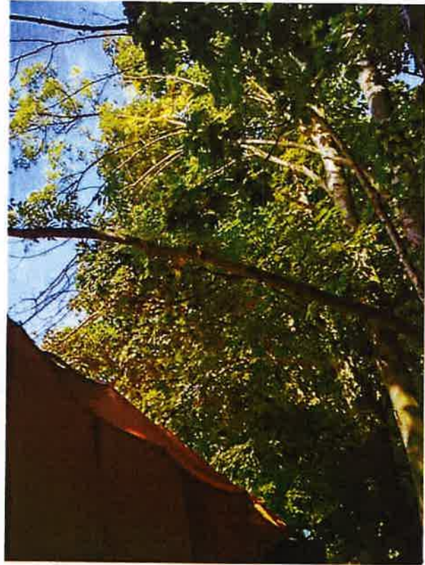
Výrazně proschlé koruny přístřešky
