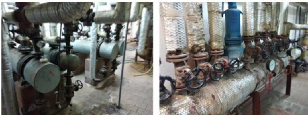
Obr. č. 5 – Výměníky (VS poliklinika)
