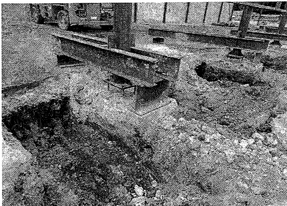
Stav při opravě patek sloupů v ose A na objektu SO 03
