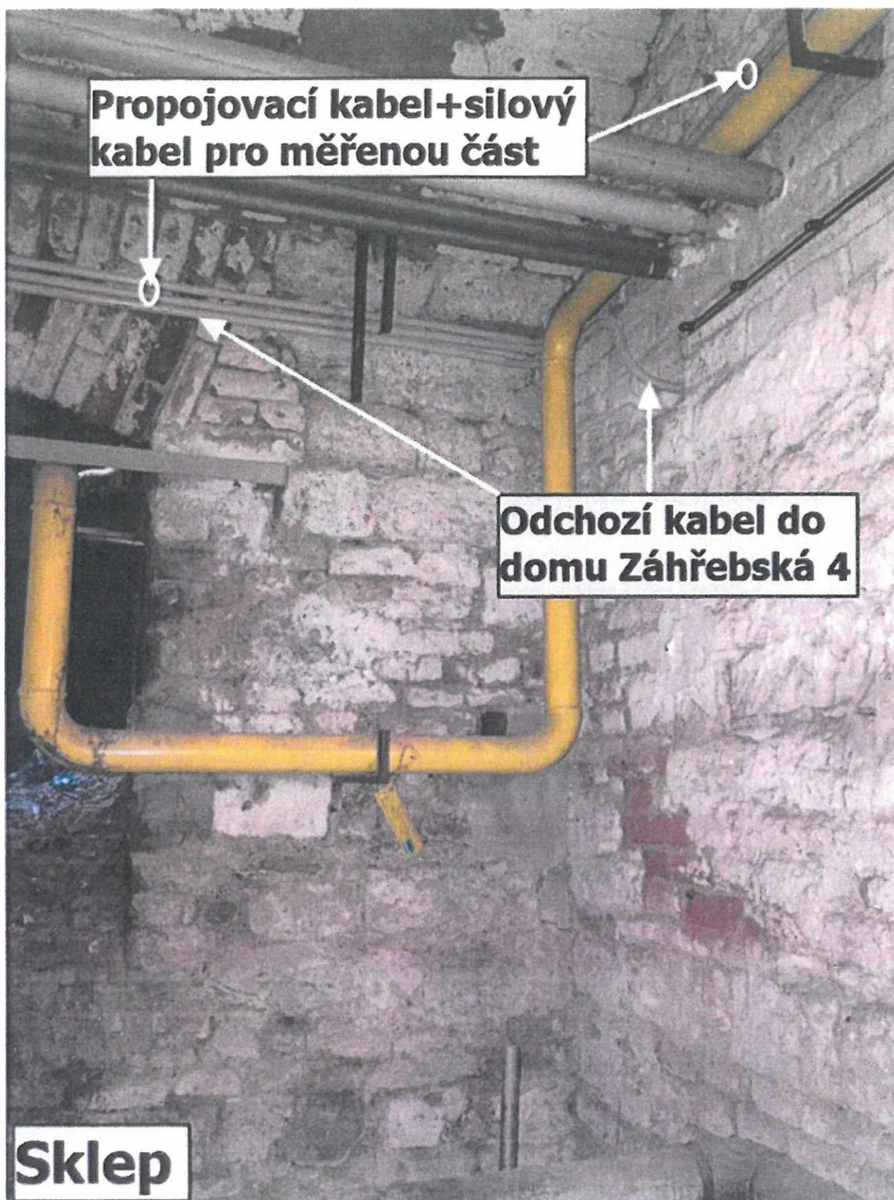
obr. 3 Část trasy odchozí, propojovací a silové kabeláže ve sklepe
