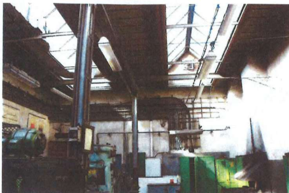
Nezateplené stropní světlíky
