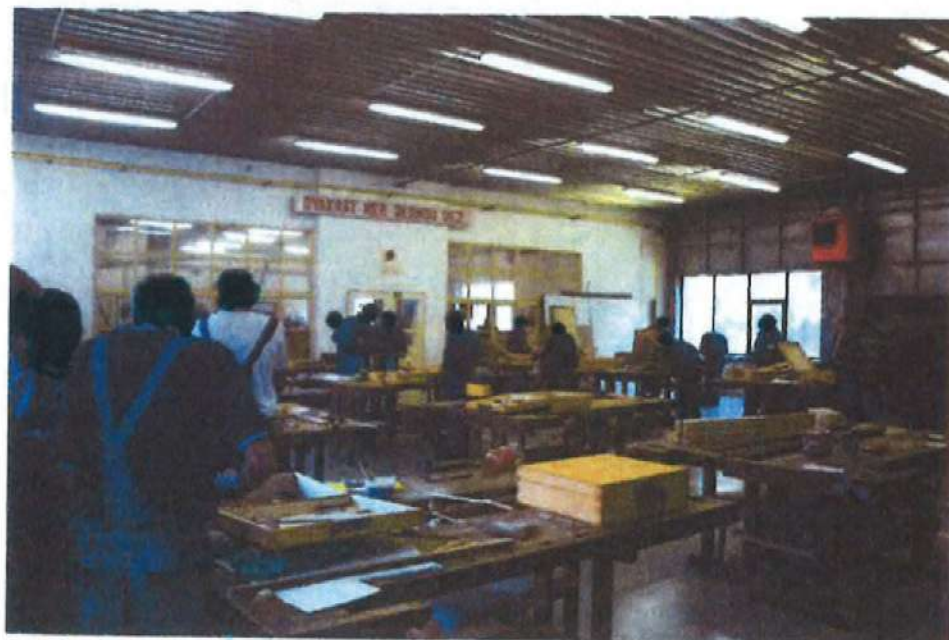
Nedostatečné zateplení stěn a stropů
