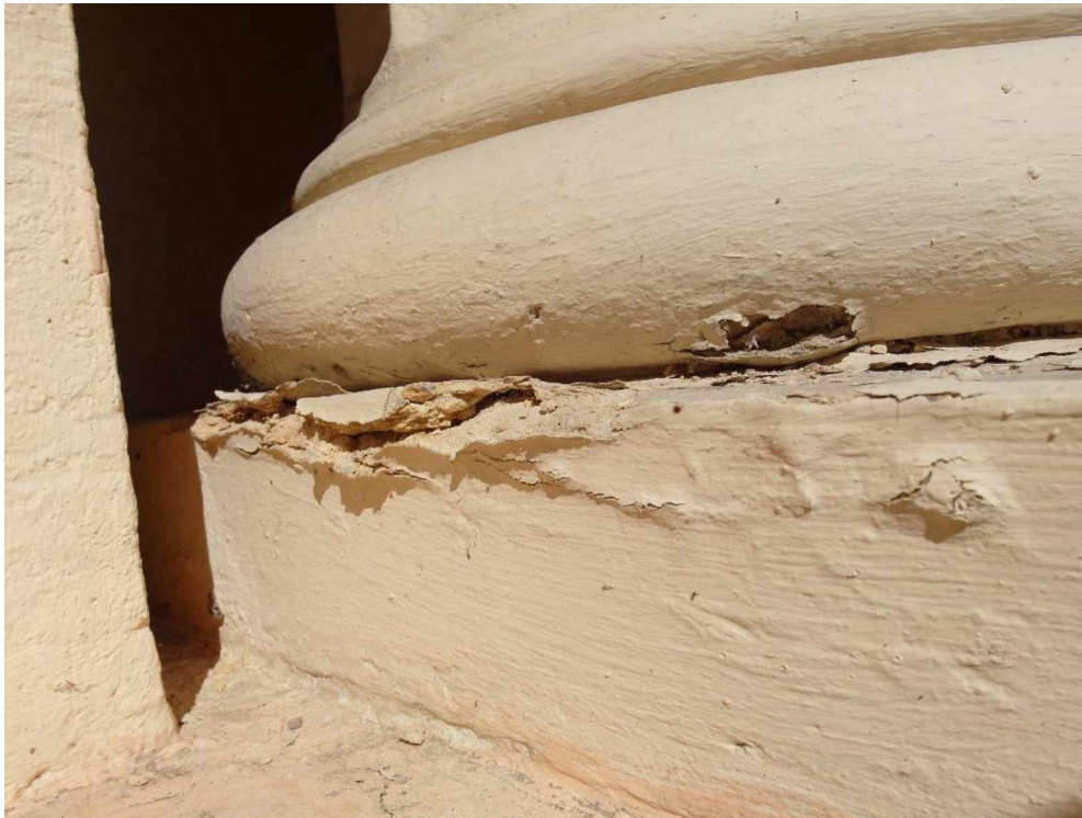
Pomník carských důstojníků, detail poškození patek sloupů
