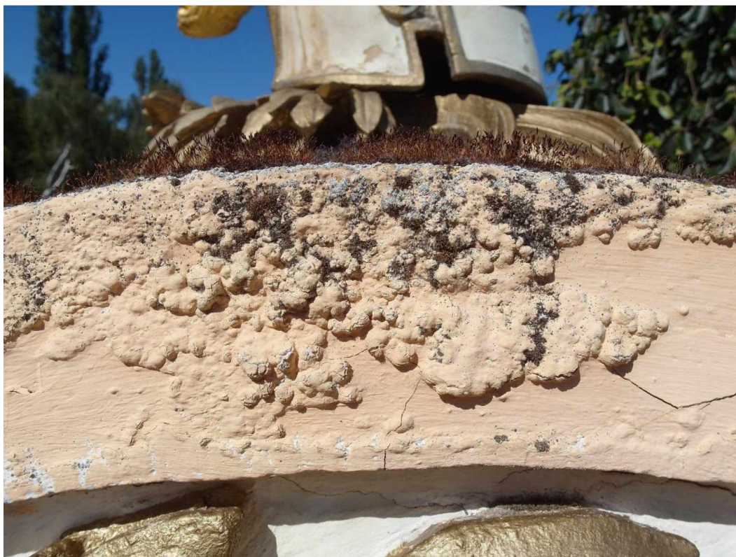
Pomník carských důstojníků, detail mechu a poškození na okraji frontonu
