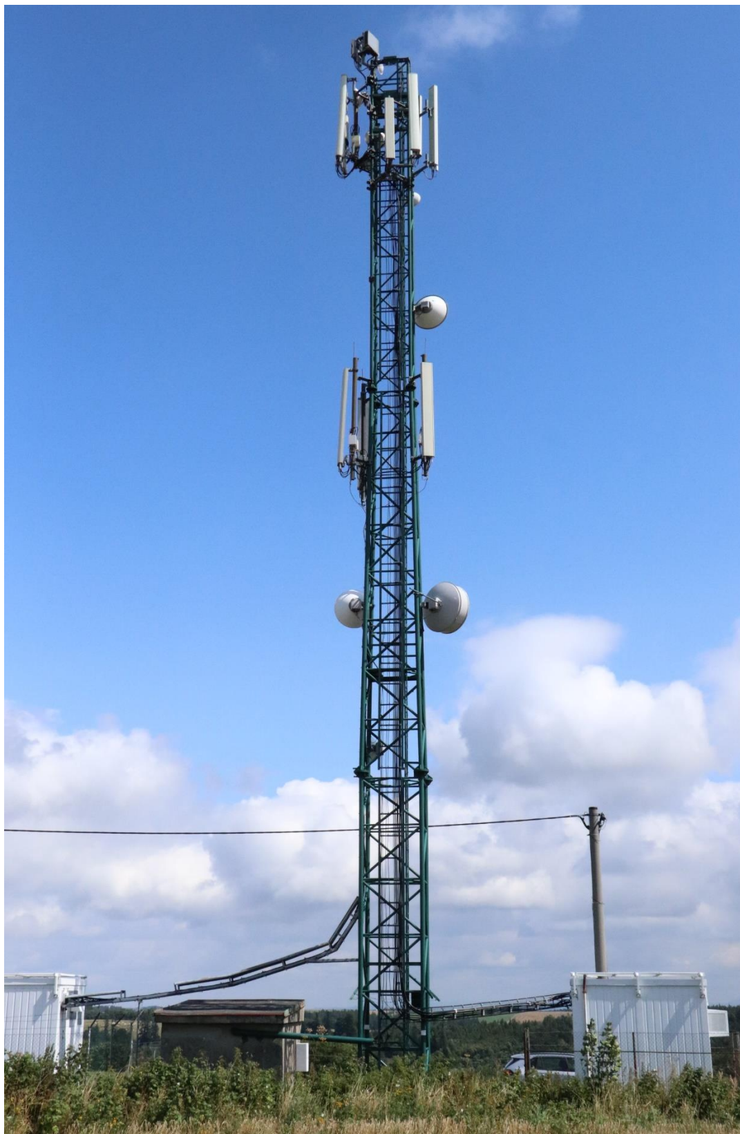
Obr.1 Pohled na stanoviště Potštát
