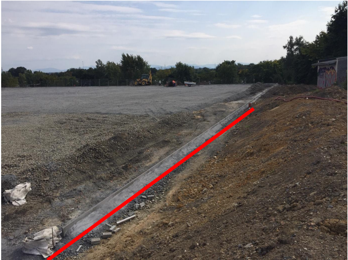
Odvodňovací žlab - doplnění na SZ straně
