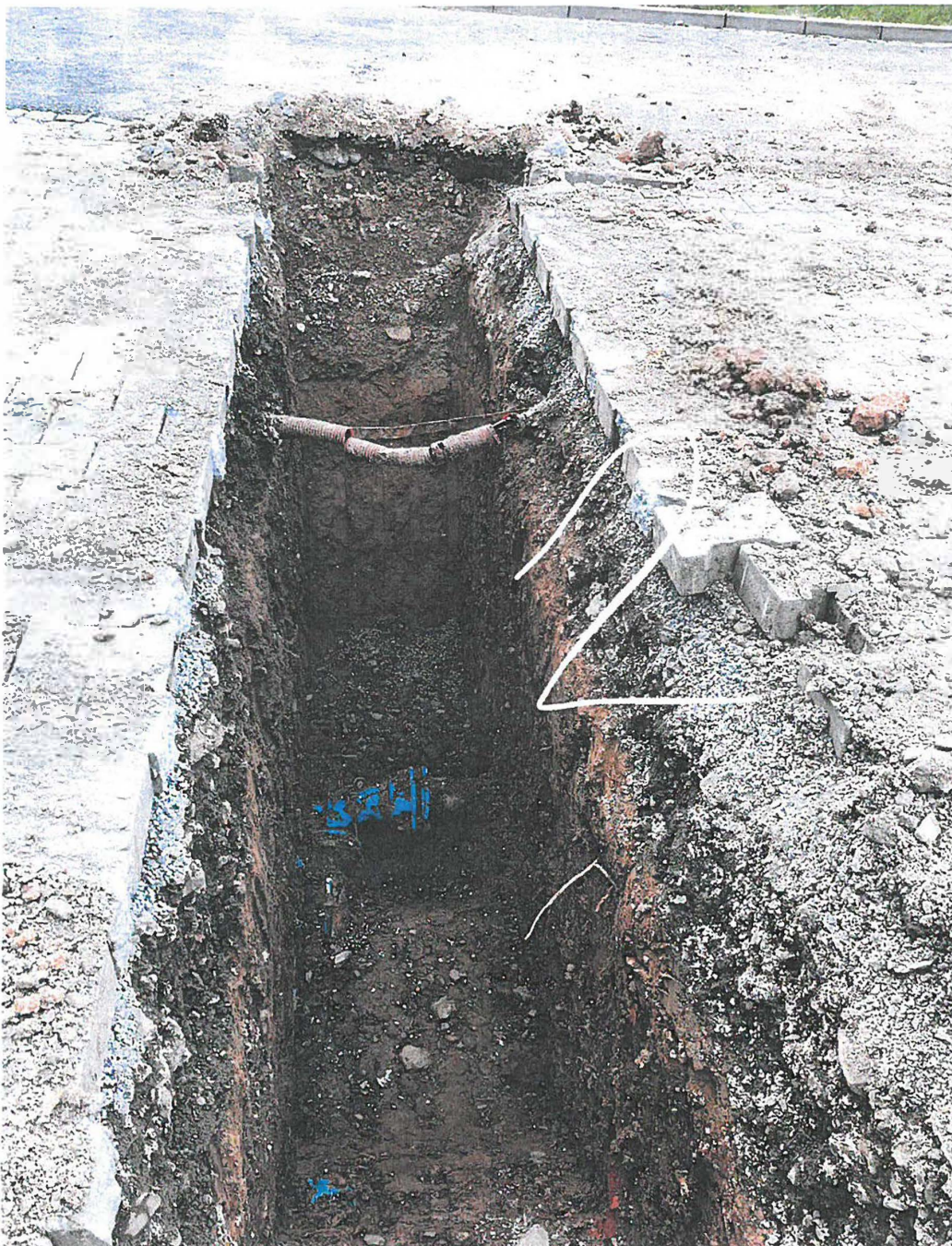
4) Přeložka vody - stav po odhalení
