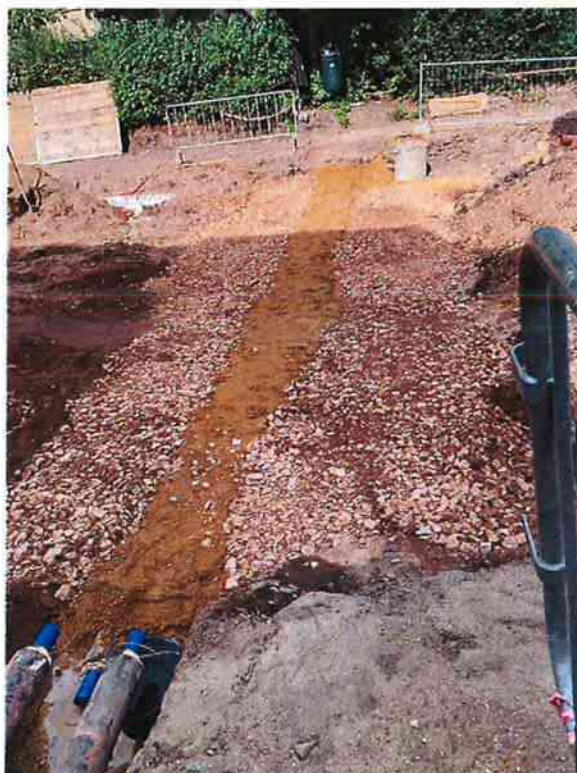
Zásyp potrubí po změně nivelety před betonáží krycí desky - Přeložka ČEZ Teplárenská
