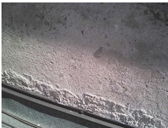
Fotografie č. 2- Poškozená omítka na budově strojovny – spodní část
