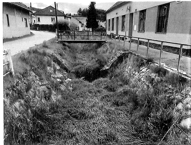
Úsek B – ř.km 3,830 – 3,878
