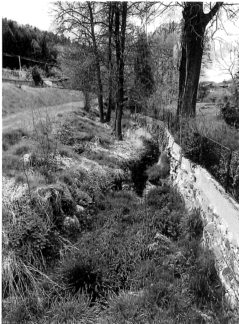
Úsek D – ř.km 4,165 – 4,175
