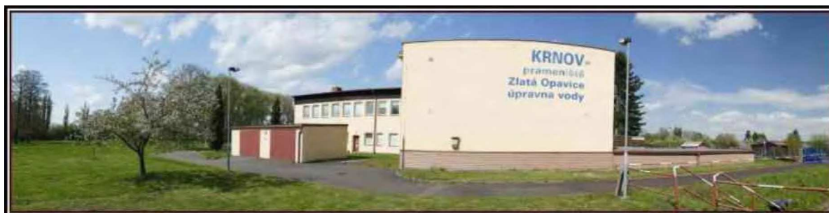
Foto: Úpravna vody Zlatá Opavice
