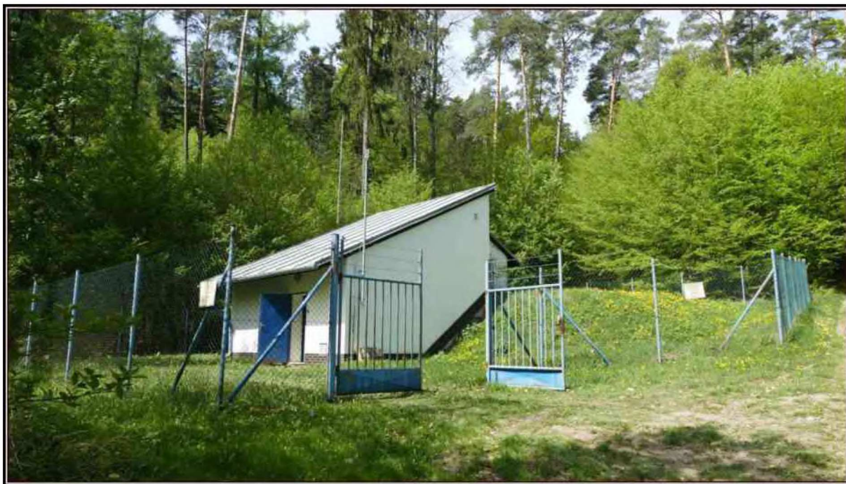
Požadavek na zabezpečení objektu:
