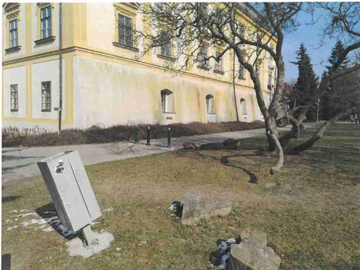
Oprava základu stávajícího odpadkového koše
