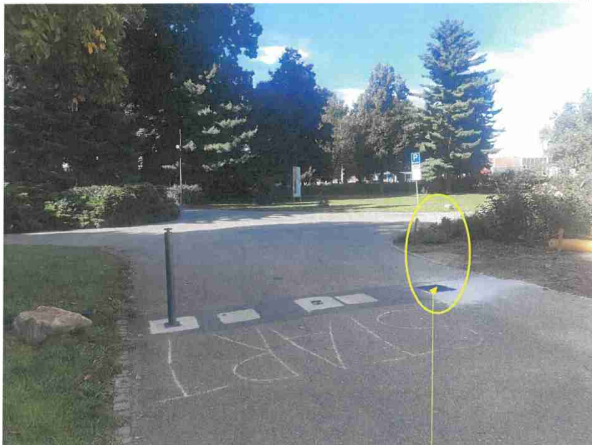
Osazení 1ks nového zahrazovacího sloupku Donat DON150, odnímatelného
