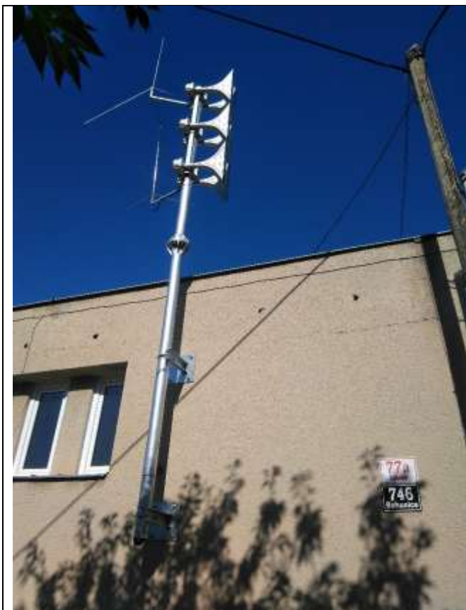
Obr. EST.16-1 – nová elektronická siréna eRotor 750F se 6 ozvučnicemi a anténami VIS a JSVV
