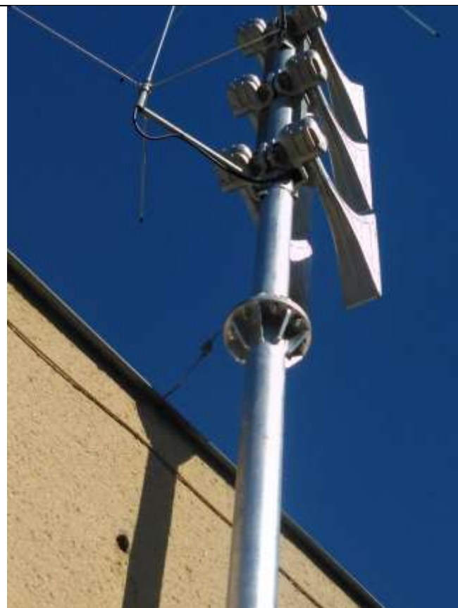
Obr. EST.16-2 – detail stožáru, 6 ozvučnic na novém stožáru,
