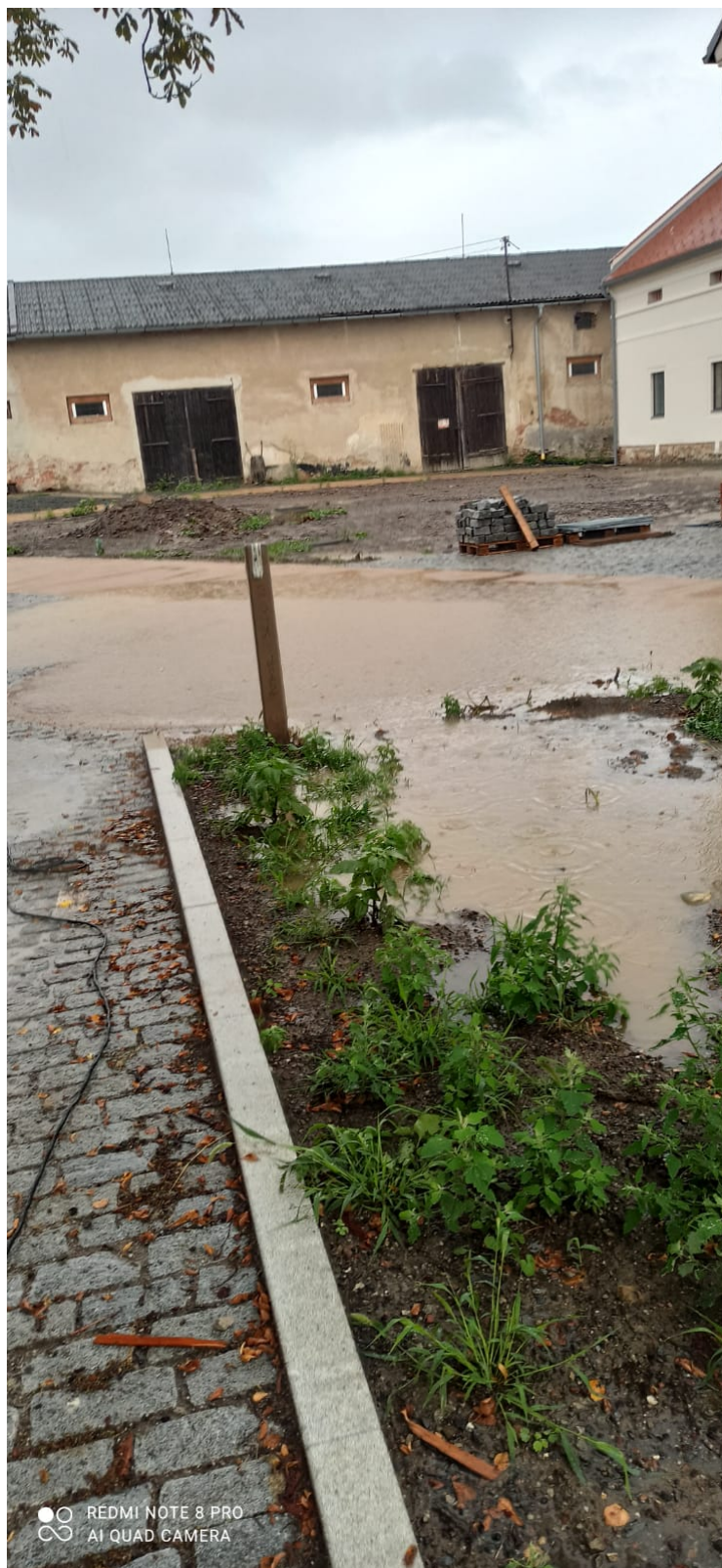
Z 73 (nedostatečný však srážkové vody do terénu)
