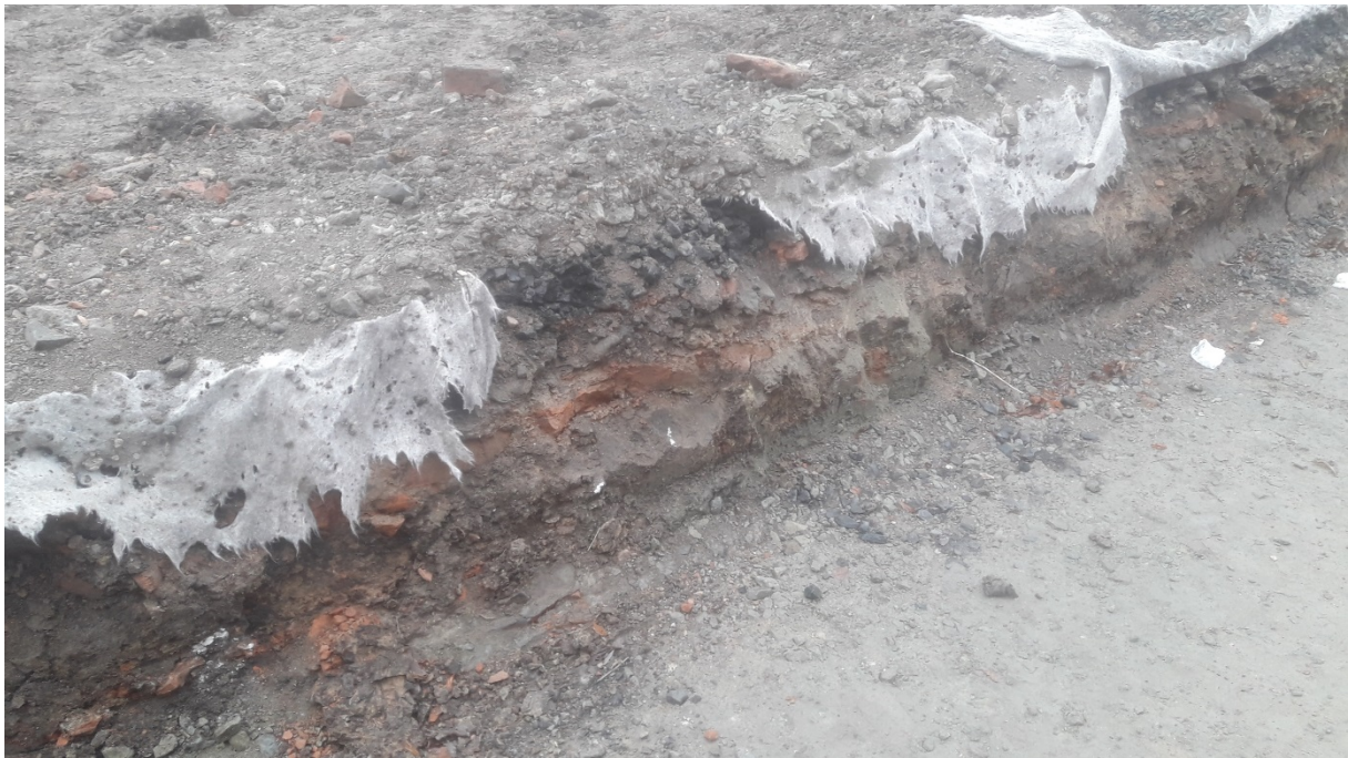
Z 35, Z 37 (komunikace – násyp ze stavebního materiálu)
