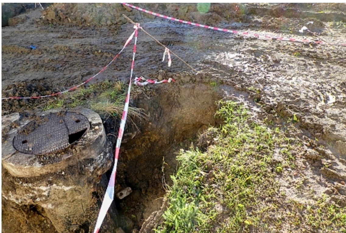
Z 34 (výkop pro připojení splaškové kanalizace)
