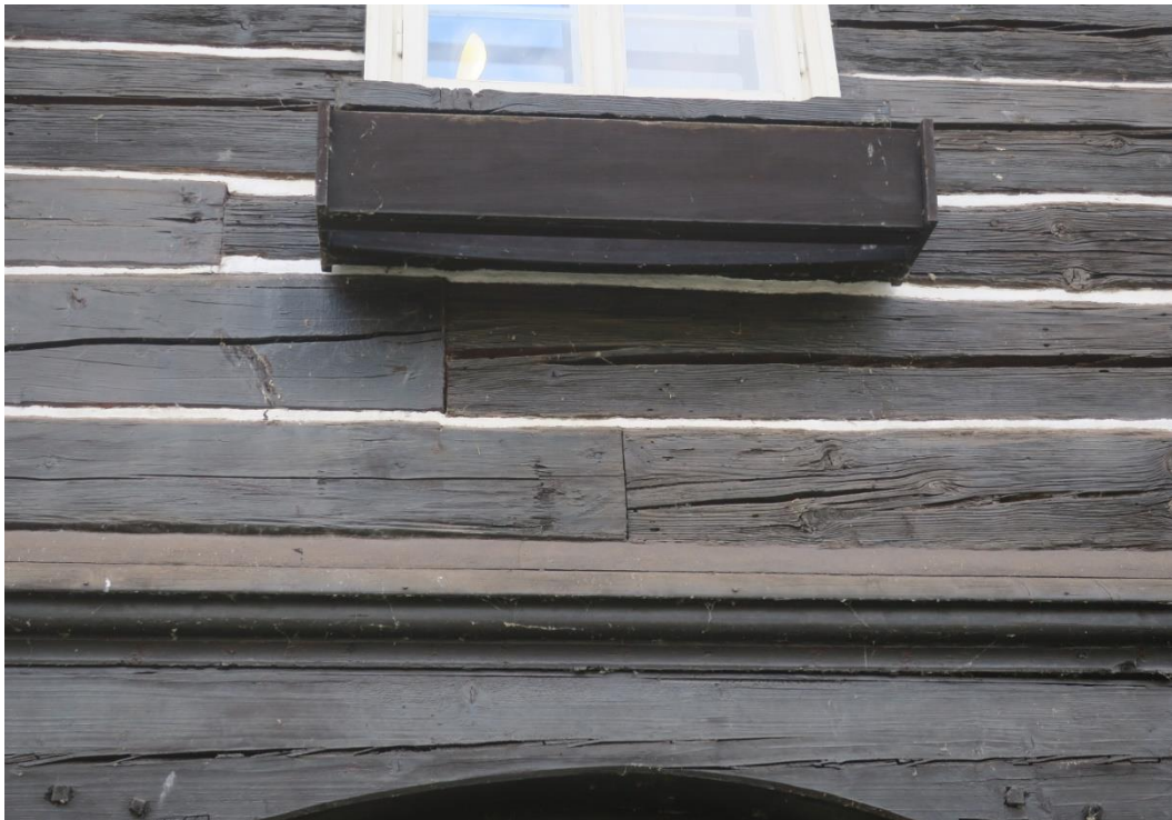
Detail vyměněného roubení v roce 2020 a původní stěny
